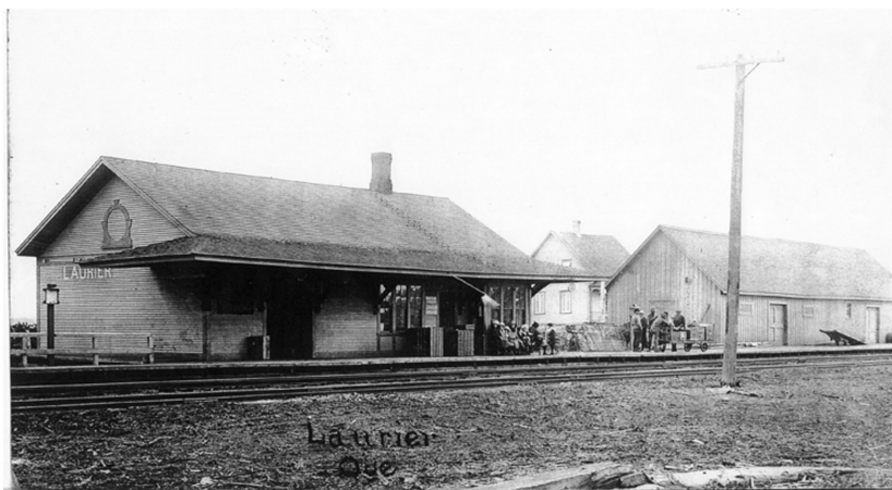
Premier édifice de la gare de Laurier-Station, en opération de 1899 à 1918.
